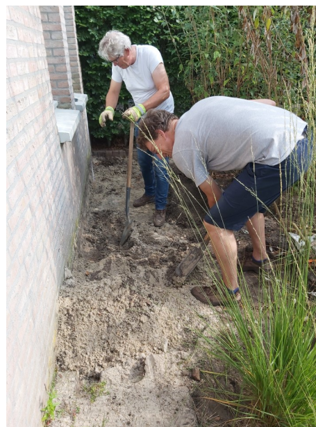
vrijwilligers leggen de basis voor een waterreservoir, waardoor de regenpijp kan worden afgekoppeld
